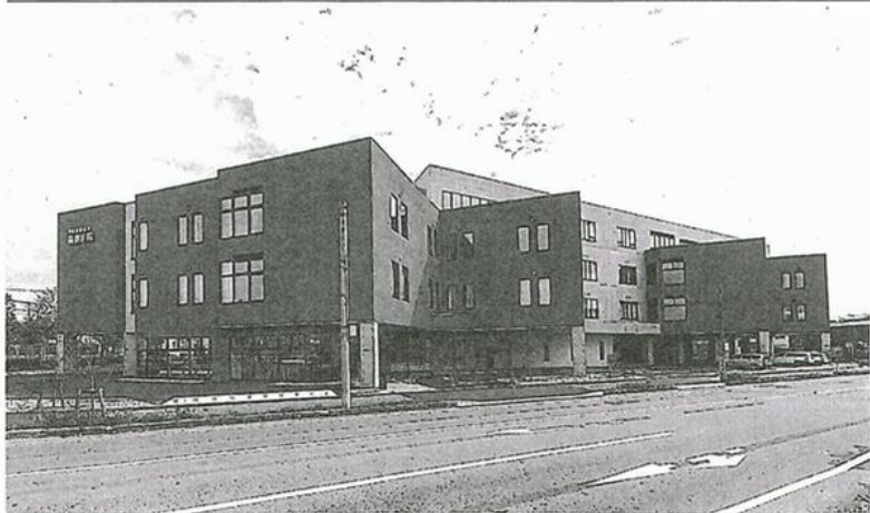
新病院には、クラスター型の設計を採用。外観もユニークな作り
